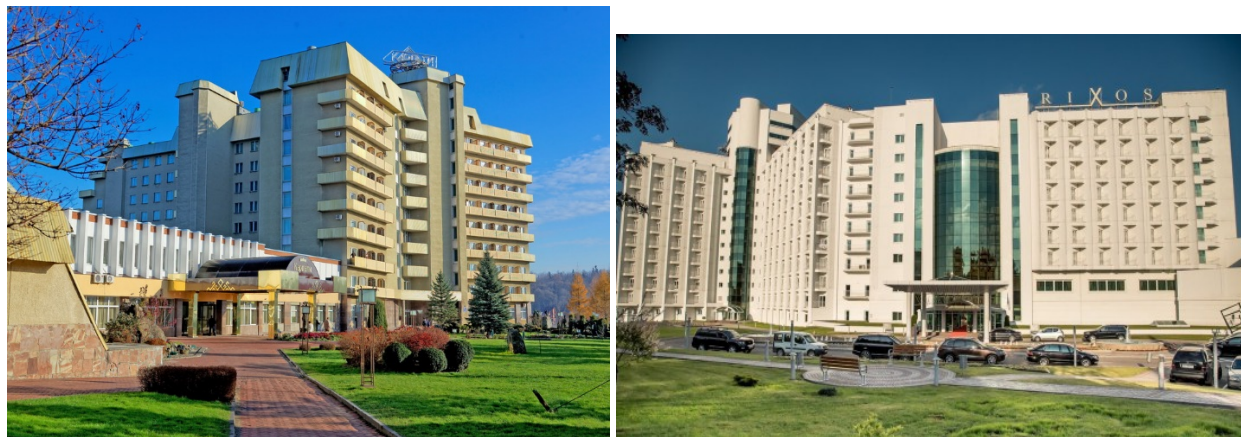
Рисунок 2.12. – Санаторії міста Трускавця.
