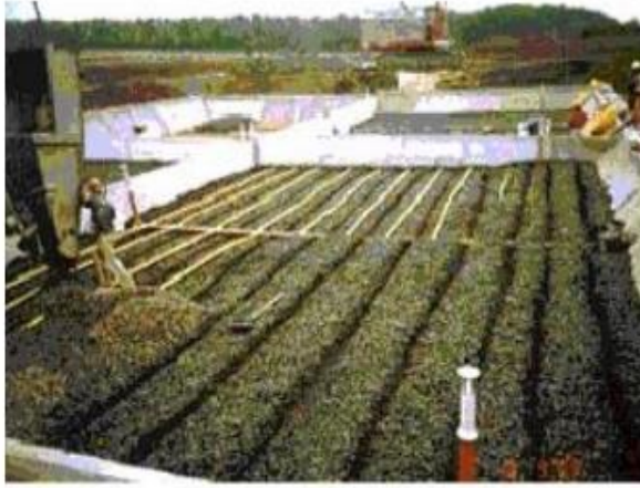
Рис.1.6. Біологічний ставок для очищення стічних вод
