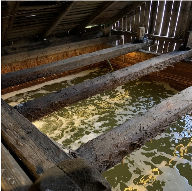
Рисунок Д.1. Росоло-збірник (відстоєння та очищення ропи)
